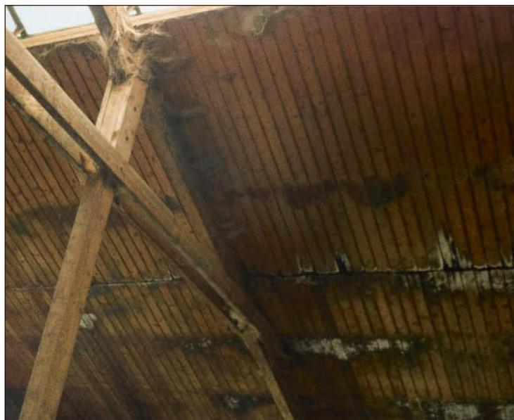
La formation de moisissures et l'accumulation de poussière sous la toiture permettent de conclure à une mauvaise qualité de l'air dans l'étable.
